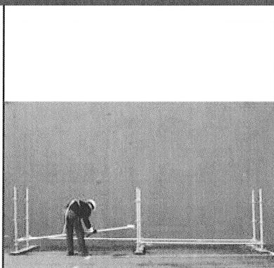
Positionner les vérins sur des cales en bois. Mettre les poteaux de départ sur les vérins et dimensionner la maille voulue en assemblant les longerons aux poteaux.
