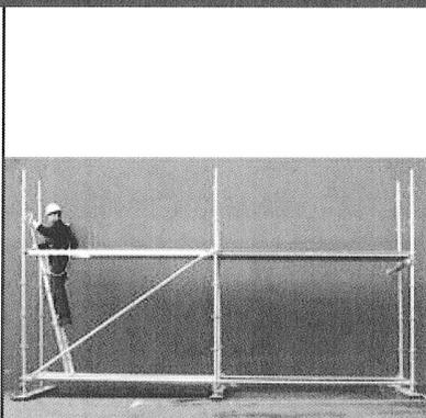
Accéder à l'étage supérieur en utilisant un équipement de protection individuel. Des éléments de protection collective sont disponibles dans notre gamme (garde-corps provisoire de montage, garde-corps de montage et d'exploitation).
