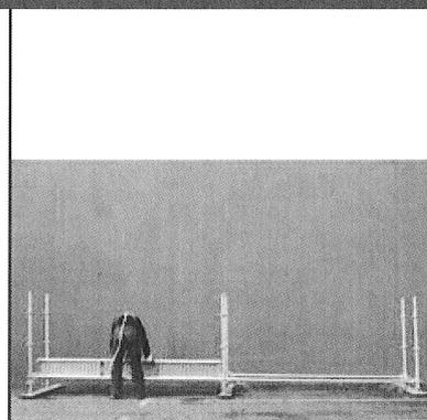
Poser les planchers pour la maille réservée à l'accès, ainsi que des planchers d'aide au montage.
